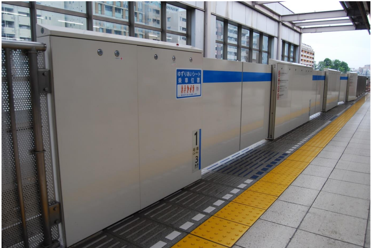
扉がガラスでない場合のホームドア ブルーライン センター北駅にて撮影
